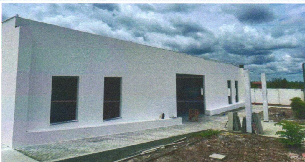
3) EMASSAMENTO DAS PAREDES
